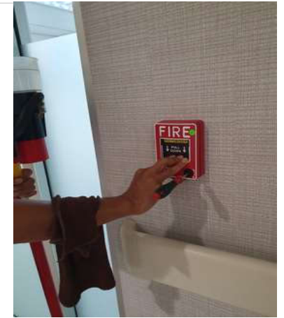
ทดสอบการทำงาน Manual pull down
