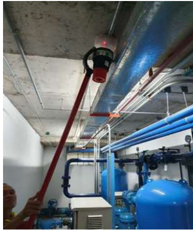
ทดสอบการทำงาน Smoke detector
