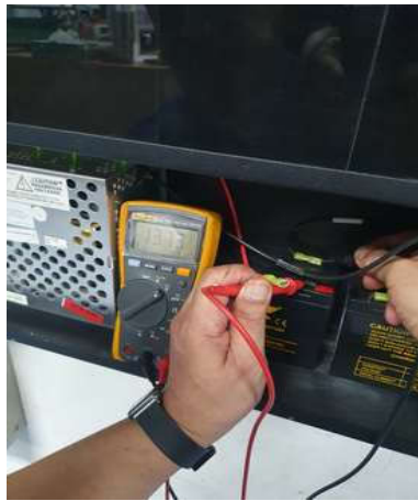
ตรวจสอบ วัดค่า Battery Backup ชุดที่ 1
