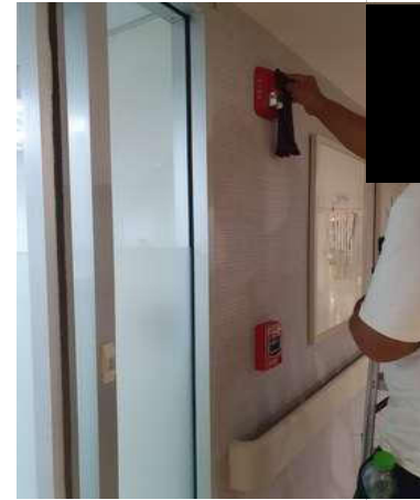
ทำความสะอาด Manual pull down และ ชุด Horn with Strobe
