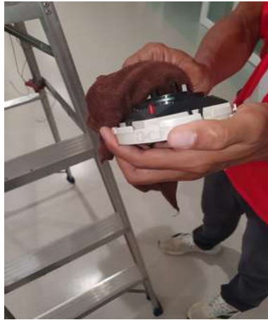
ทำความสะอาด Smoke detector
