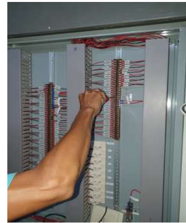
ไขแน่น Terminal ตู้ Module
