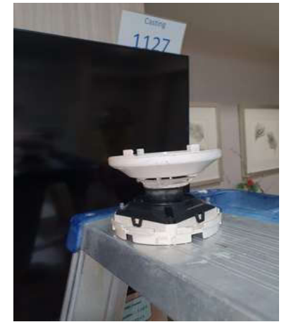
สภาพ Smoke detector ก่อนทำความสะอาด
