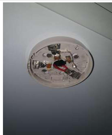
สภาพ Base Smoke detector ขาดชุด เป็นสนิม
