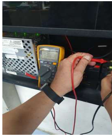
ตรวจสอบ วัดค่า Battery Backup ชุดที่ 2
