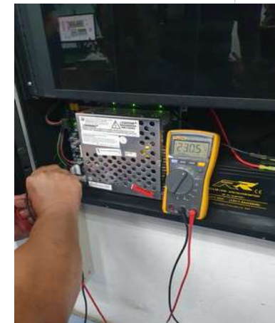
ตรวจสอบ วัดค่า Main Power Supply
